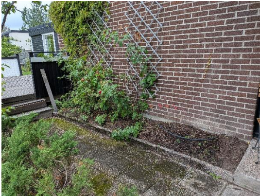
Växtlighet i anslutning till grundmur/fasad.
