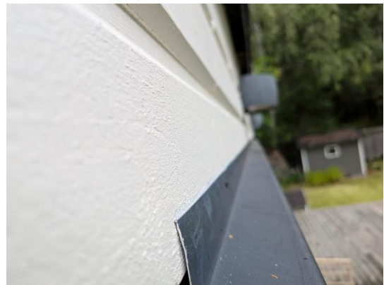
Droppbleck ovanför fönster.
